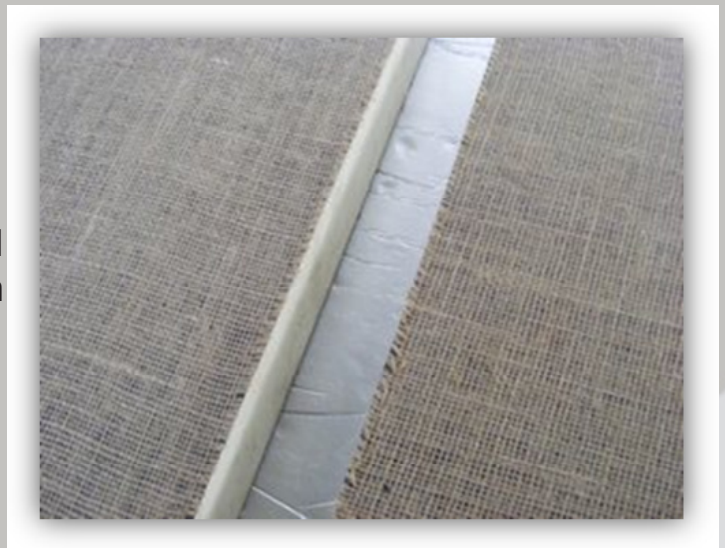
Figura11 - Corretto accostamento pannello
