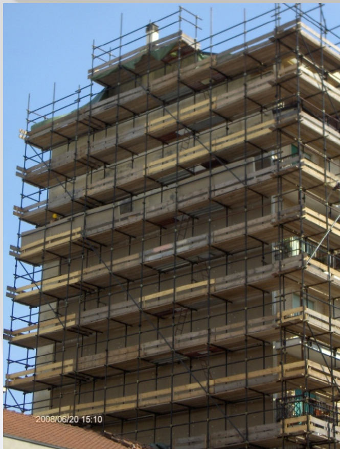
Figura 4 - Ponteggio allestito per intervento di cappottatura
